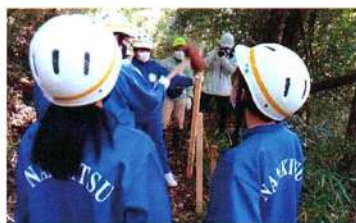
ロープ班 散策道のうち、斜面に接したところに転落防止のためのロープ張り。杭を2本、3本と打ち込むうちに、掛矢の使い方のコツをつかみ上手に打ち込めた生徒もいました。
