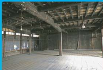
2階内部。間仕切りの跡や室名札が残っている
