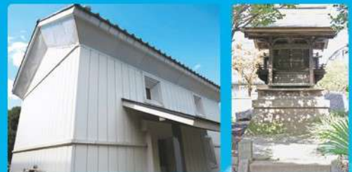
写真左の土蔵は内部に火災の痕が残る。稲荷社は本格的な造りで、当時の塩原家の勢いを示す
