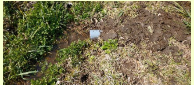
塩ビ管を新たに埋めて、水の流れを調整
