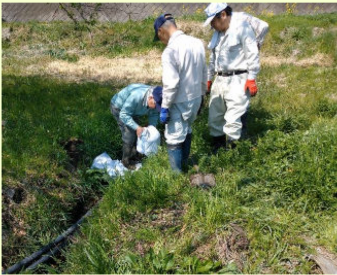
土のう袋で、水の流れを調整
