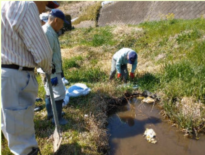
土のう袋で、水の流れを調整
