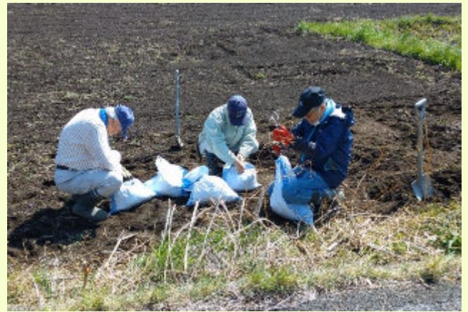
まずは、土のう袋作り
