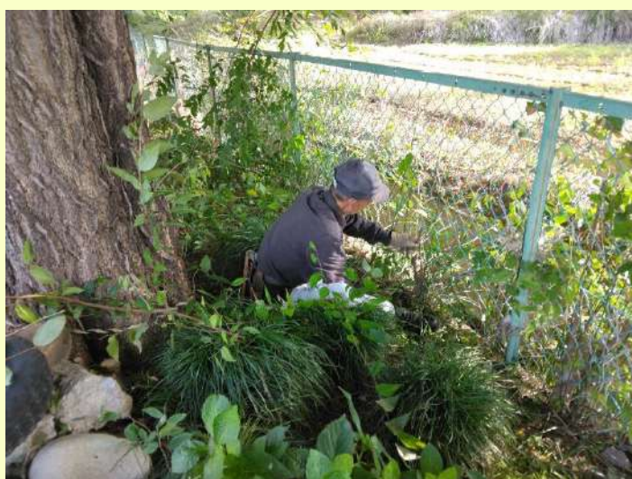
フェンス際の雑木除去
